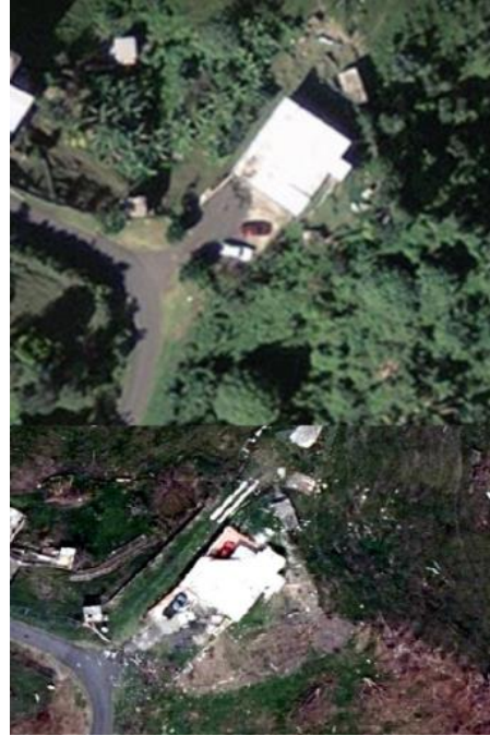
Figura 5 Vista Aérea Antes (arriba) y Después (abajo) del Huracán
