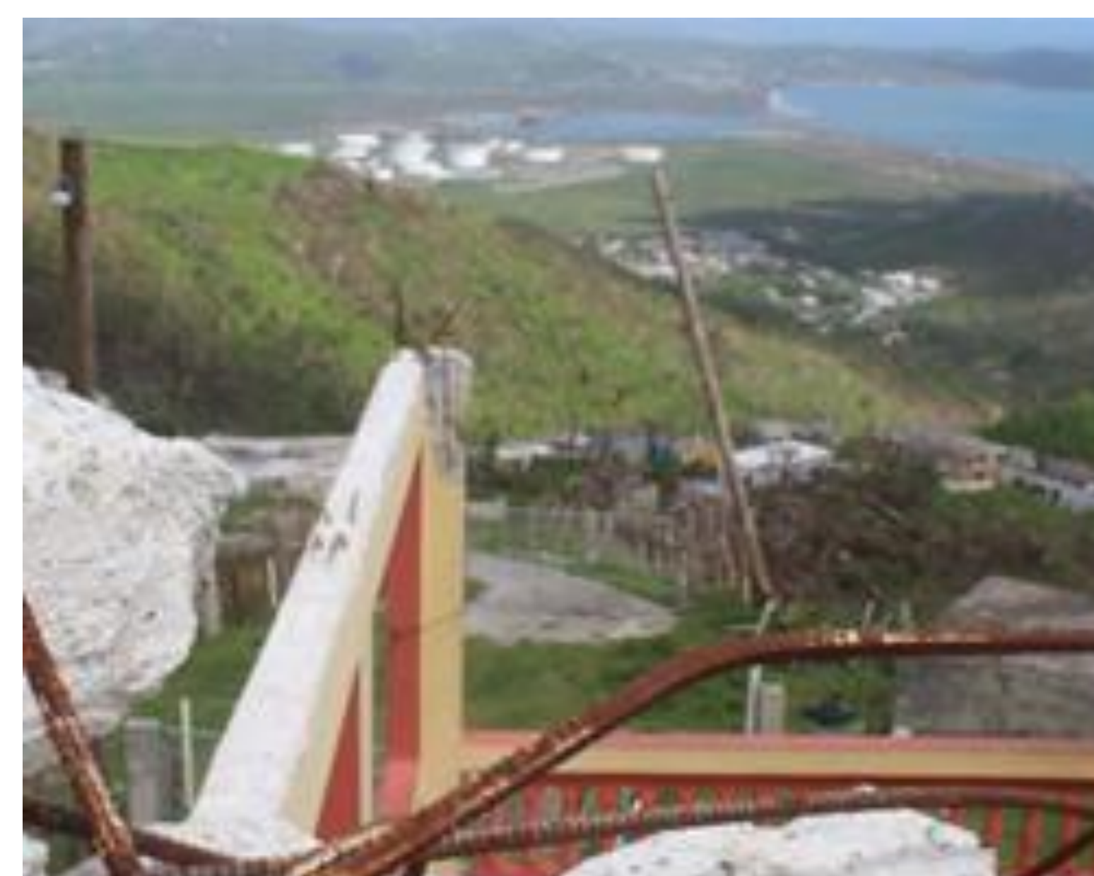
Figura 4: Anclaje viga y Columna
