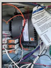
Figure #3: Controlador Local con “relays” Instalado en Unidad de Aire.
