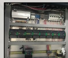
Figura #4: Controlador Maestro Instalado en las facilidades del Centro Comercial.
