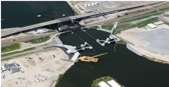
Figura 7 Vista Aérea del Dique Seabrook
