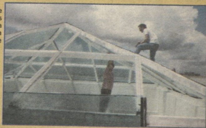
Los empleados de servicios generales reparando el domo de la Biblioteca temporeraamente
