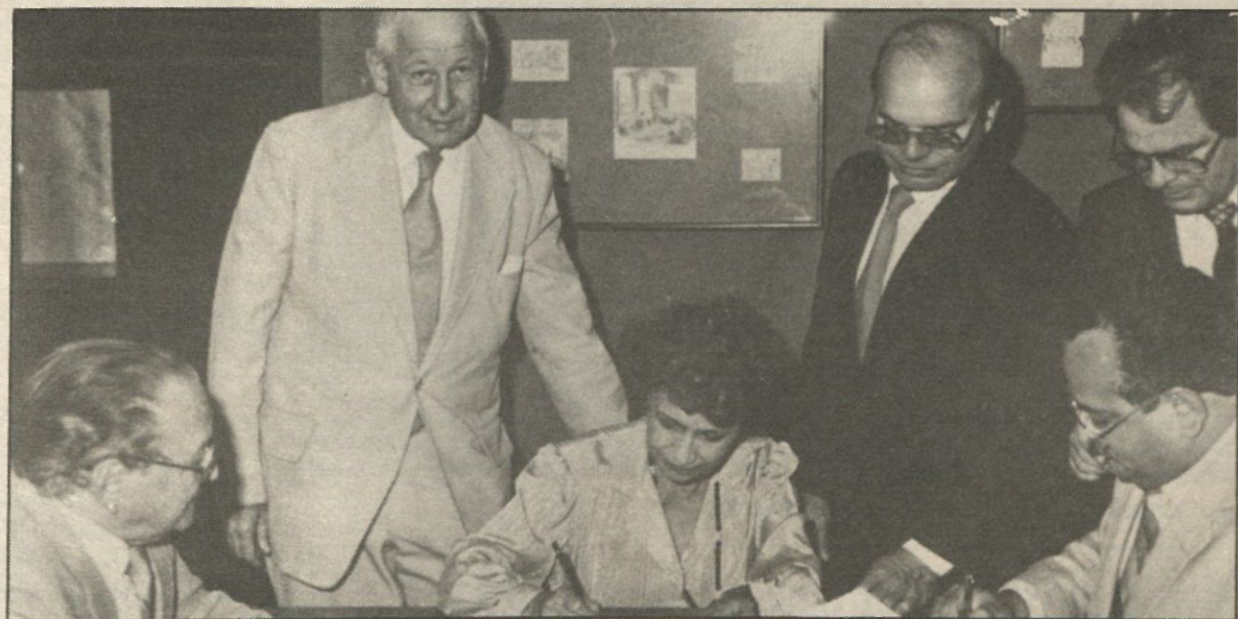
Histórica foto tomada el 23 de Diciembre de 1986, durante la firma de los documentos de adquisición de los edificios y terrenos de la antigua clínica Juliá, que fueran remodelados y adaptados para servir de sede a la Universidad Politécnica de Puerto Rico. Aparecen sentados, de izquierda a derecha, Don Ernesto Vázquez Torres, Doña María Lina Juliá de Margarida y el Prof. Ernesto Vázquez-Barquet. De pie, el Dr. Carlos José Margarida Mora, el Lic. Jorge R. González Vizcarrondo y el Lic. Irving A. Jiménez Juarbe.
