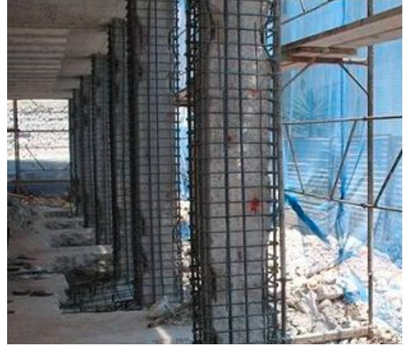
Figura 11 RC jacketing en columnas
