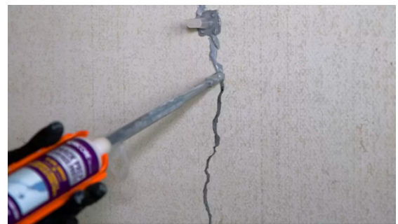
Figura 12 Sellado de grietas con material epóxico
