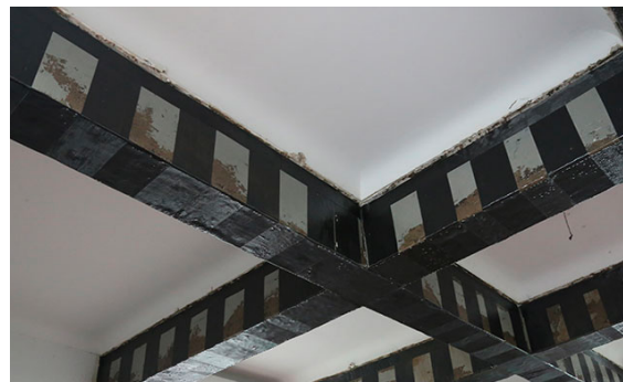
Figura 10 FRP jacketing en vigas
