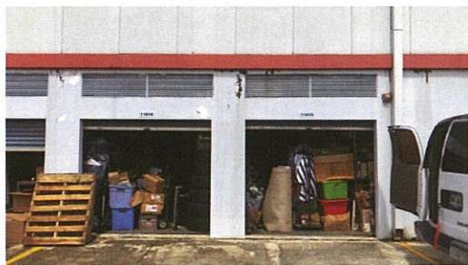
Figura 2 - Estado Actual del Almacén
