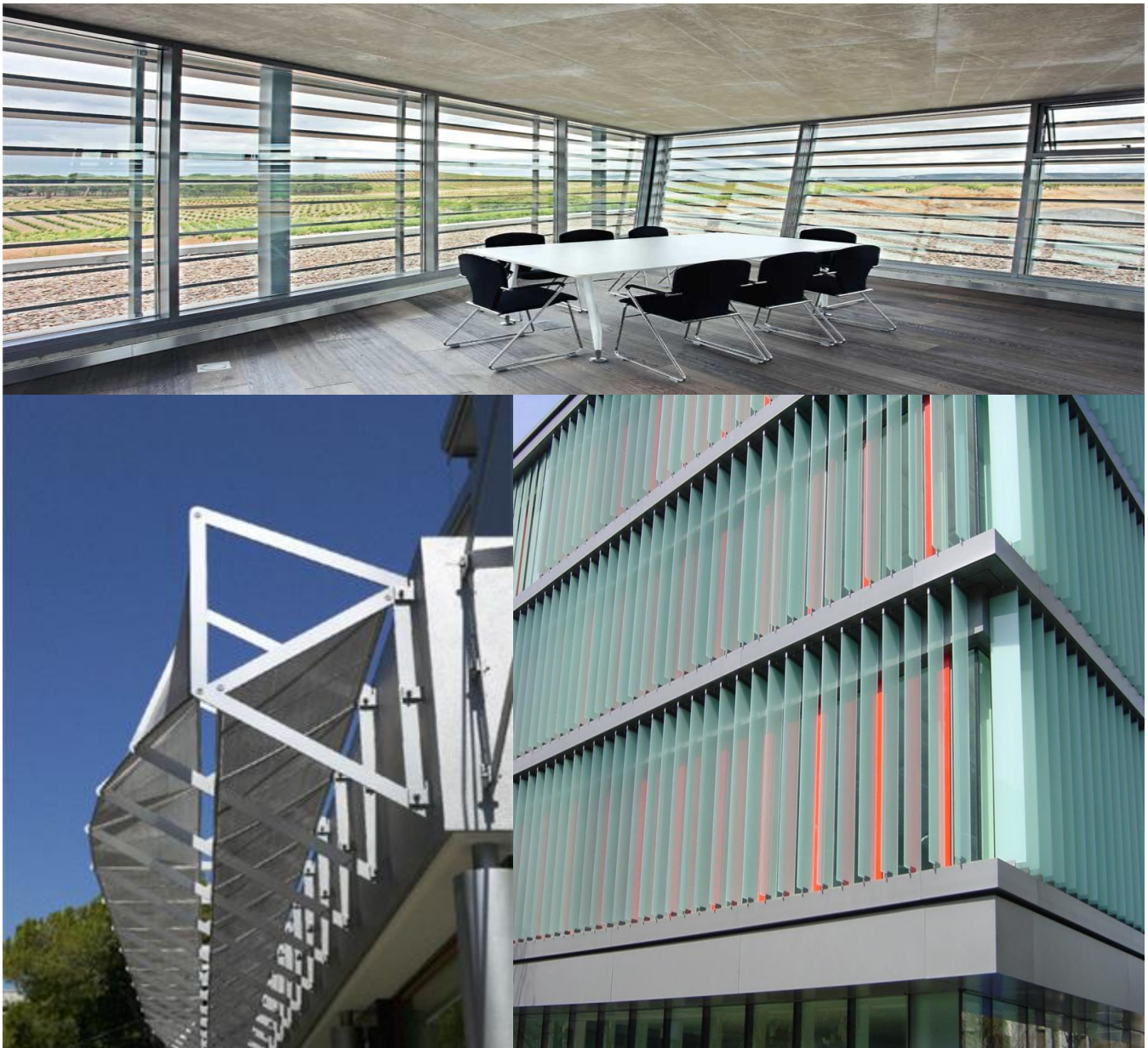
Figura 13: Utilización de Sistemas de Protección Solar
