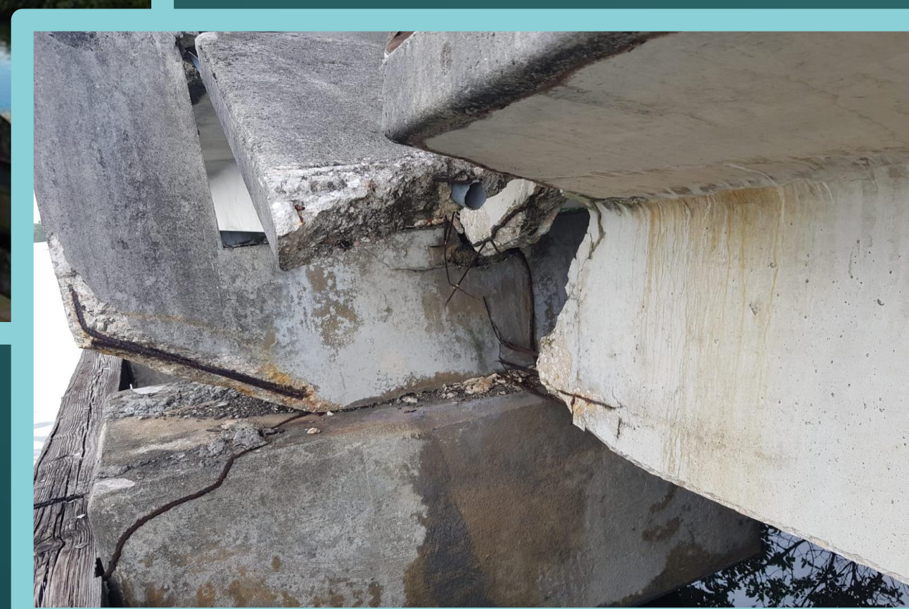
Actual Damage Slab
