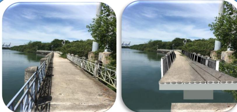
Superficie de Rodaje Existente de 8 pies. Superficie de Rodaje Propuesto de 14 pies.
