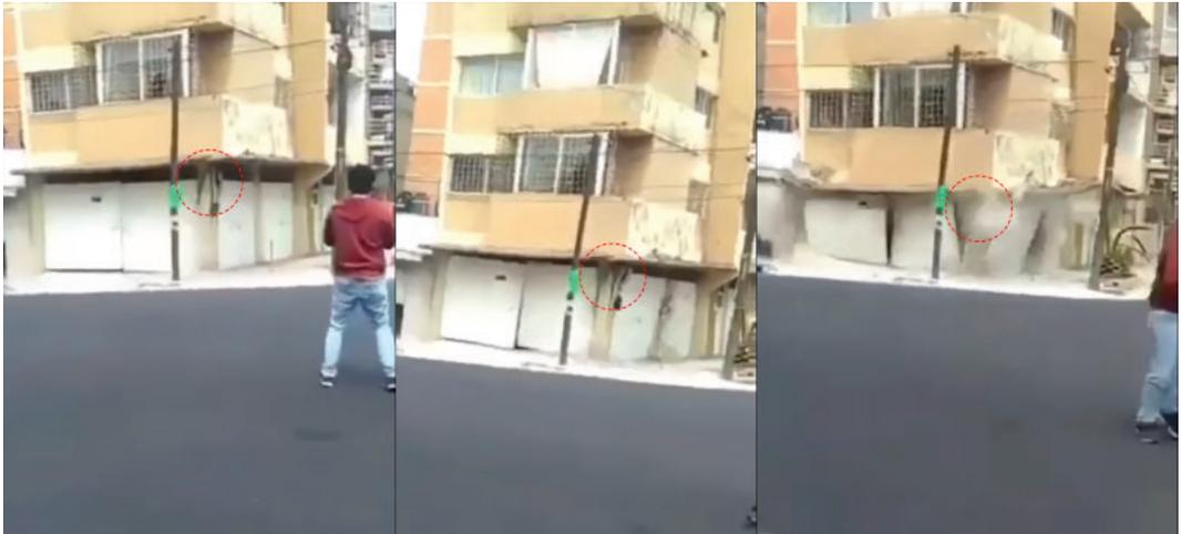
**Imagen 5. Fragmentos de video, mostrando la falla estructural de una columna de un edificio habitacional. (Fuente: @OBLIX/YouTube)**
