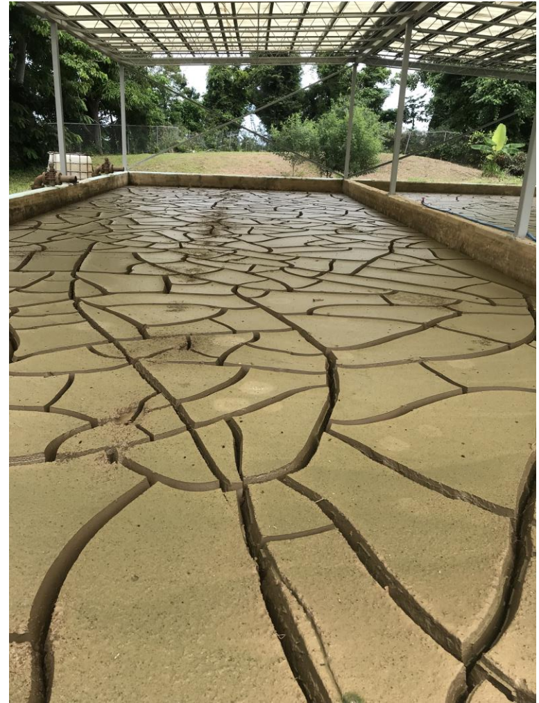
Lodo en Proceso de Desagado
