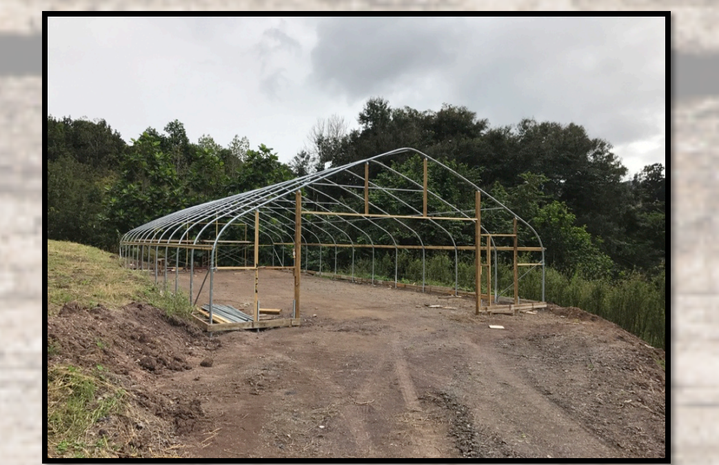
Figura 6 Vista existente de esqueleto de la estructura
