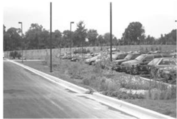
Figura 5 Ejemplo de una Facilidad de Bioretención en un Estacionamiento en Estados Unidos
