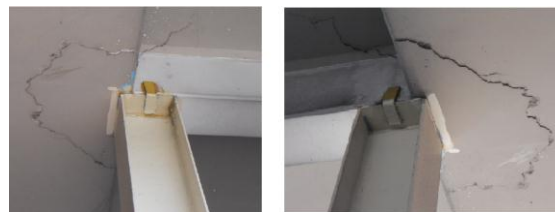
Figura 1 Empuje de Cortante.
