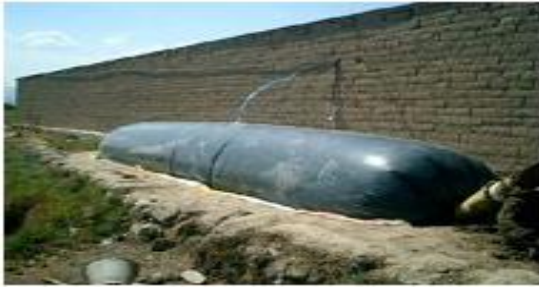
Figura 7 Fotográfica de la Construcción de un Biodigestor de Balón Plástico [11]
