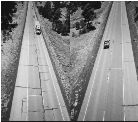
Figura 6 Arizona después de 8 Años de Rendimiento Izquierda Asfalto Convencional, Derecha Asfalto de Caucho Modificado [3]
