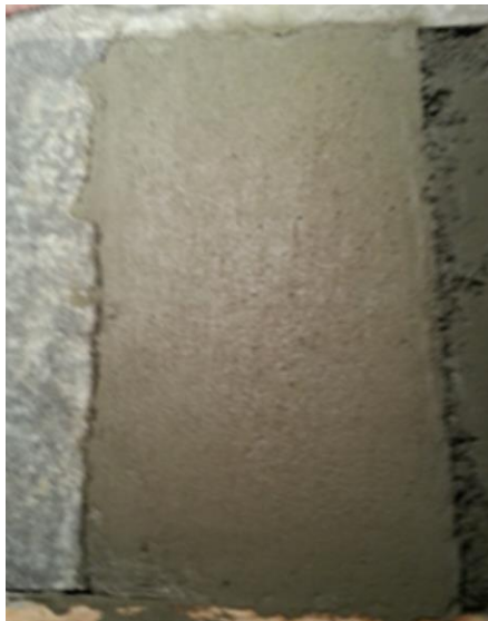
Figura 4 Capa de recubrimiento de Mezcla Control
