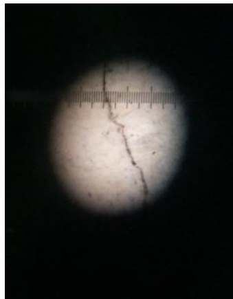
Figura 12 Medición de grietas - Mezcla #1
