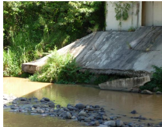
Figura 5 Estribo Derecho Puente PR-149
