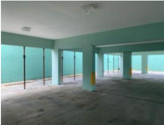
Figura 2 Estacionamiento del Primer Nivel del Edificio
