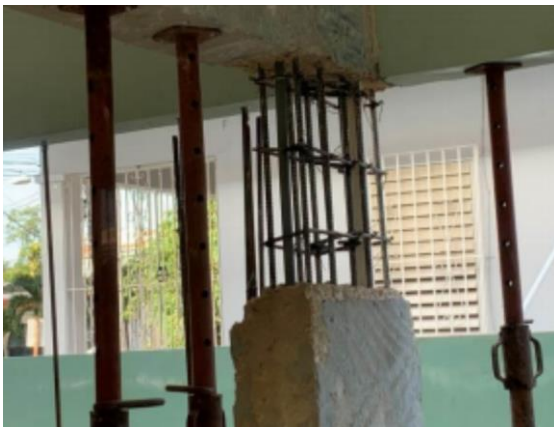
Figura 6 Distribución de Aros en Columnas
