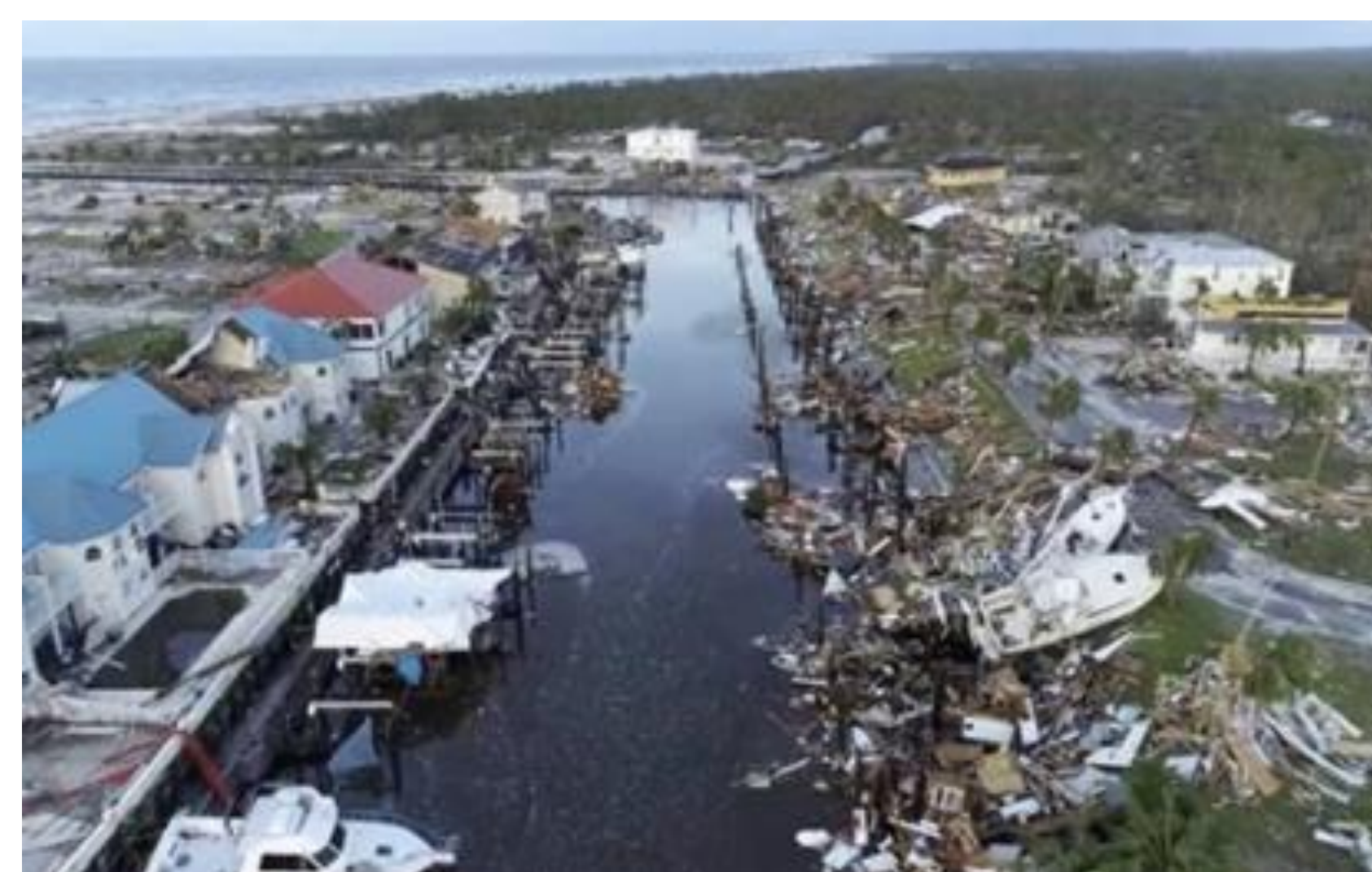
Figura 5 Daños Provocados por el Huracán George [9]
