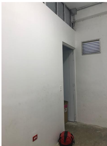
Figura 2 Pared de tablero en la escuela Julián Marrero
