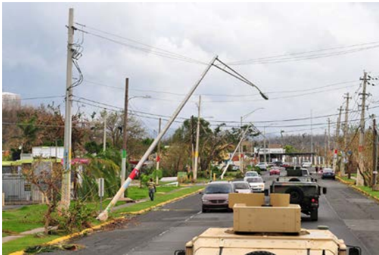
Figura 1 Poste de Luz Caído por Fuertes Vientos
