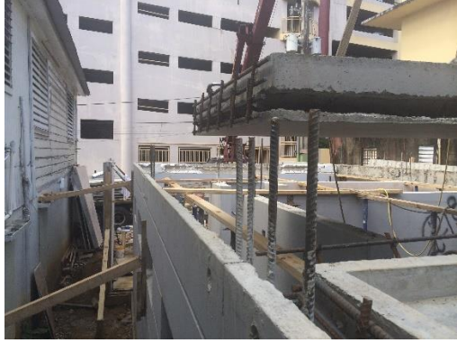
Figura 8 Día 11- IPP de Techo en Proceso de Instalación
