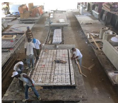
Figura 1 Construcción de un IPP de Techo en la Fábrica
