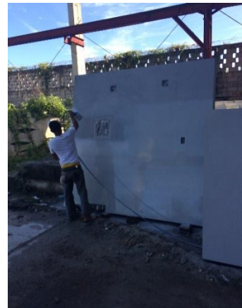
Figura 11 IPP de Pared con Panel y Cajas Eléctricas mientras se le Aplica Sellador en la Fábrica.
