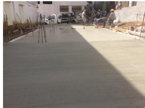
Figura 6 Día 3- Fundición de la Losa
