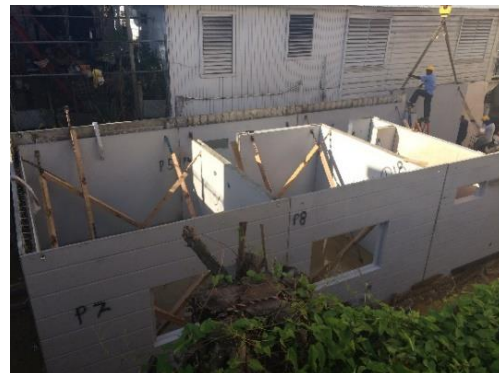
Figura 7 Día 6- IPP de Pared en Proceso de Instalación
