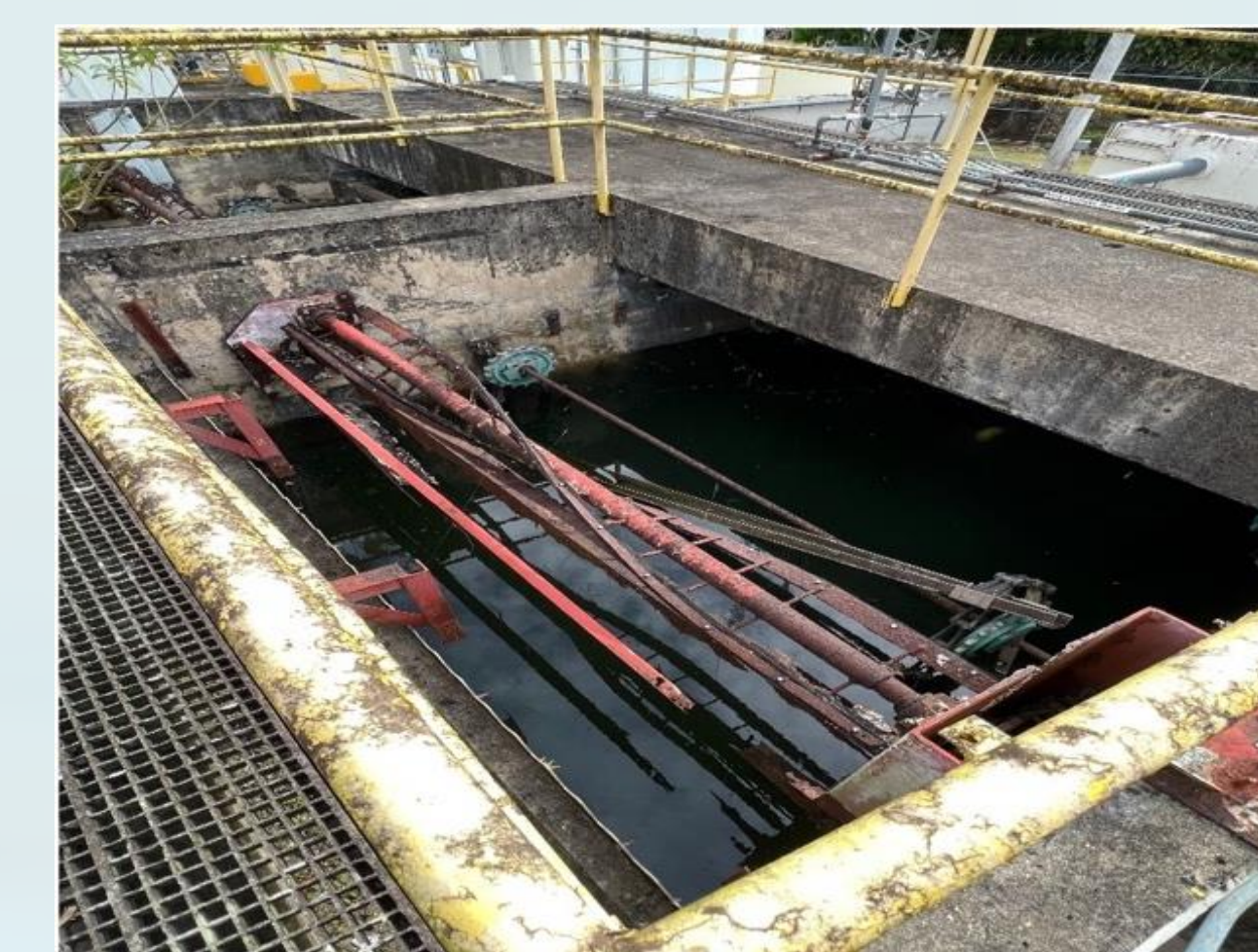
Figura 6: Área de Acumulación de Lluvia en la Antigua Planta de Tratamiento
