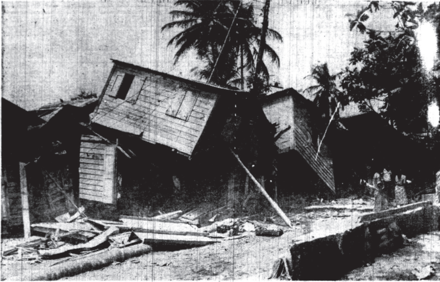
FUERZAS DESENCADENADAS: — Esta dramática escena da una idea de cuán tremendo fue el empuje destructivo de las aguas desbordadas del Rio Humacao que arrastraron estas casas de la barriada La Vega, de Humacao, dejándolas hechas escombros, a considerable distancia de donde habían sido construidas por sus dueños. El desastre dejó un balance de 82 muertos en Humacao solamente y centenares de desaparecidos. (Fotón El IMPARCIAL, por Sostre y Bouyett)
