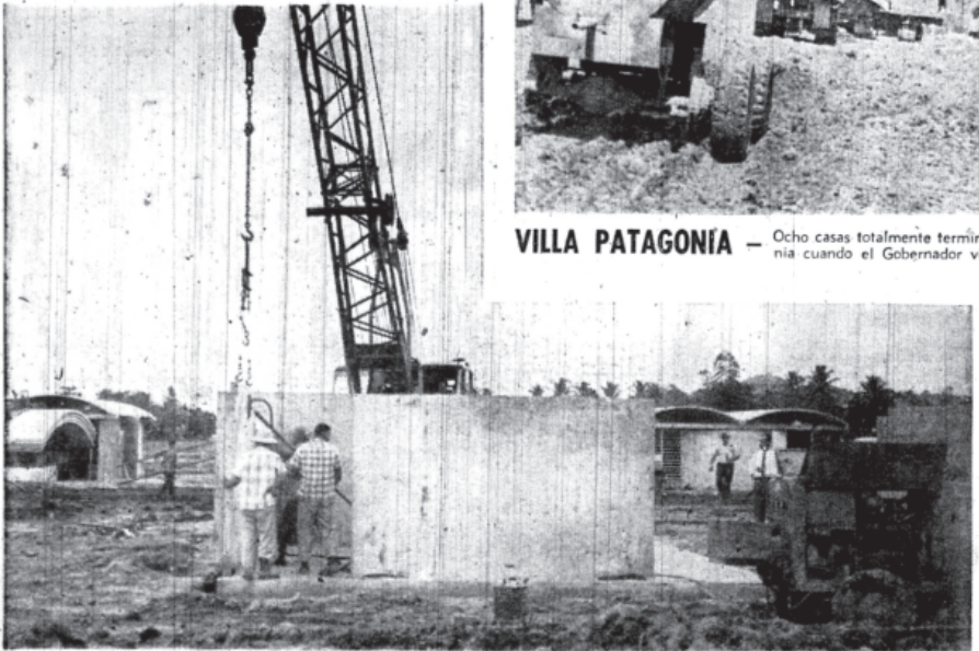
LISTA PARA EL TECHO — Con todas sus paredes instaladas, esta casa está lista ya para que le sea colocado el techo, también prefabricado en la planta de la Ibec, en Lomas Verdes, Bayamón.
