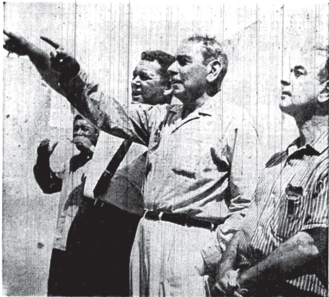
ALLI HAY MAS SOLARES — El gobernador Muñoz Marín (centro) y Thurston Ackerbloom, de la IBEC, señalan hacia los solares, inmediatos a Villa Patagonia, considerados para futuras construcciones. A a la de- na, el senador Cruz Ortiz Stella.
