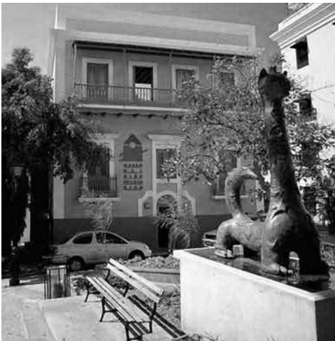
Imagen 14.3. Aspecto del edificio en la Calle del Cristo número 150, siglo XXI. (Foto: Karen J. Cuadro Esteves).
