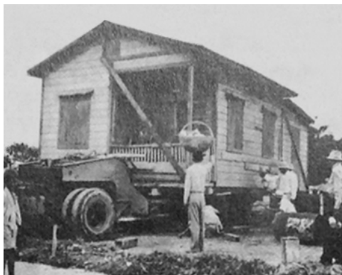
Imagen 7. Mudanza de una casa del arrabal El Fanguito a una subdivisión pública en San José, Río Piedras. (Fuente: Telesforo Carrero, Housing in Puerto Rico , Junta de Planificación de Puerto Rico, 1950).
