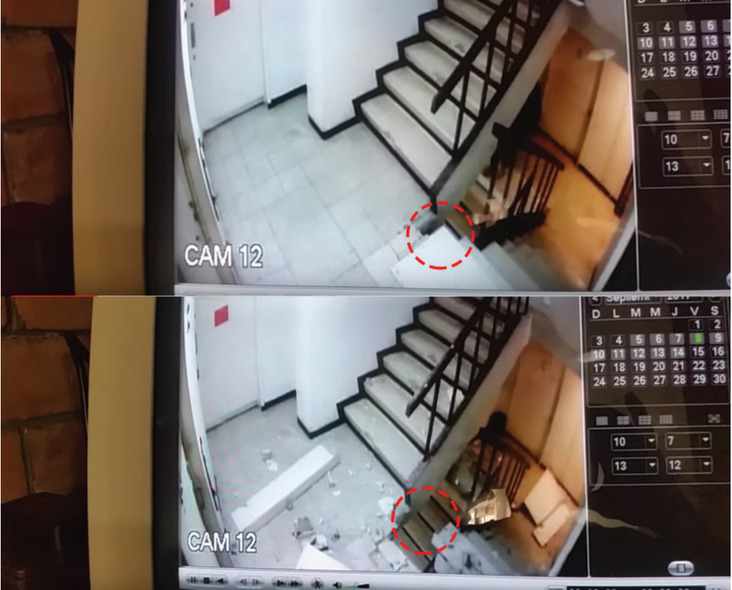
Imagen 4. Fragmentos de video, mostrando la separación que sufrieron las escaleras del edificio Osa Mayor en la Ciudad de México. (Fuente: @roclety/YouTube)
