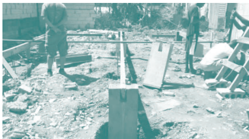
Imagen 4. Proceso de construcción de los zocos de una de las viviendas. (Fuente: TECHO/Francisco Susmel)
